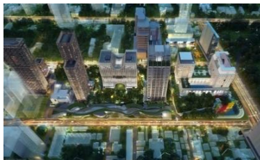
関大林組にて施工の複合商業モール「ランスワン・ビレッジ」全景
